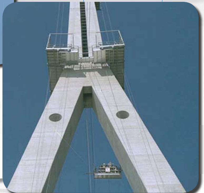
Viaduc de Wandre, Belgique
