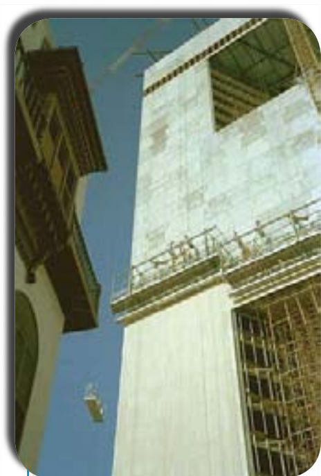
Plates-formes ALTA double niveau pour travaux de construction de façade avec ponts roulants et ascenseur guidé, Djeddah
