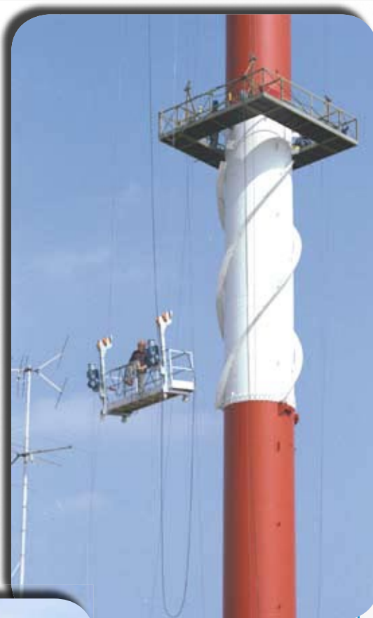
Plate-forme ALTA spéciale pour travaux sur antenne, Allemagne
