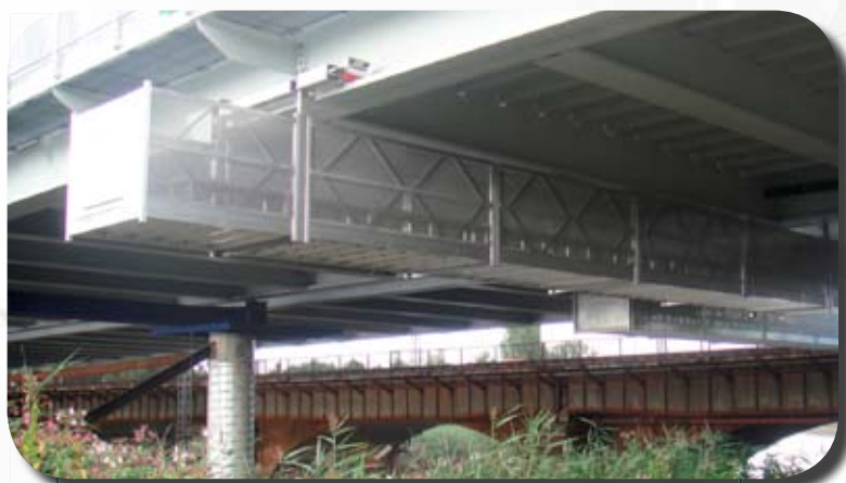
Passerelle de travail pour travaux de réparation d'un pont, Belgique
