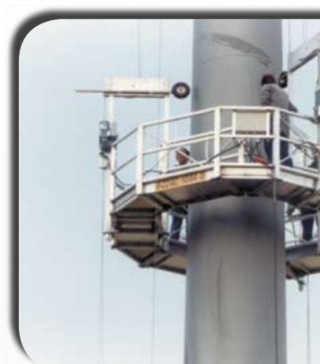
Plate-forme ALTA circulaire pour travaux sur Brême
