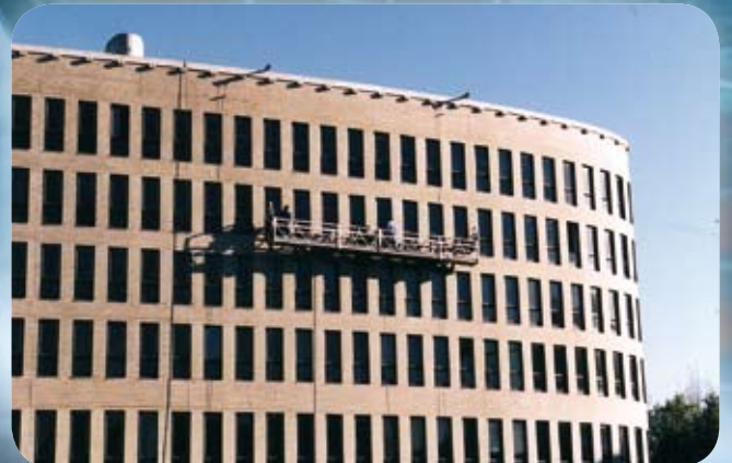
Plate-forme ALTA 8 m avec 2 suspensions PORTAFIX, Bruxelles
