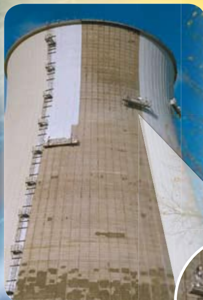
3 plates-formes ALTA 6 m, tour aéro-refrigérante, France
