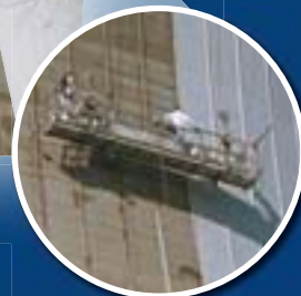
3 plates-formes ALTA 6 m, tour aéro-refrigérante, France
