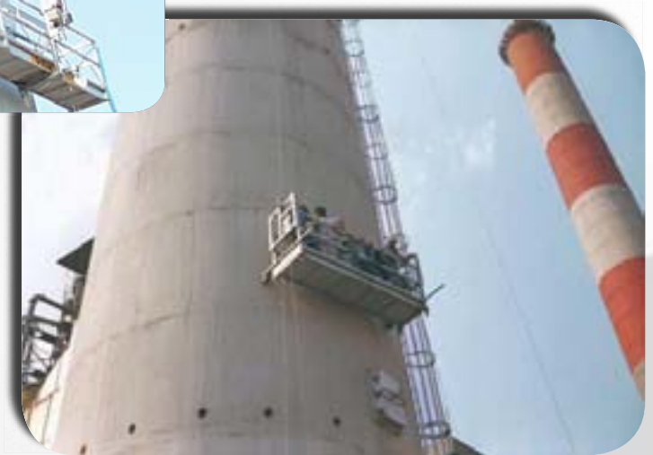
Plate-forme ALTA 4 m pour travaux sur cheminée de raffinerie, Thaïlande
