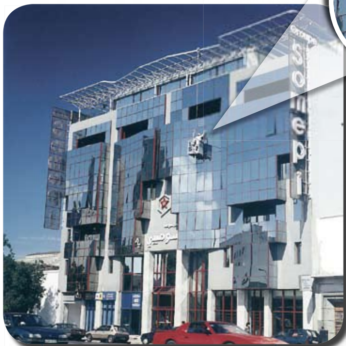
Plate-forme SOLO, application permanente avec monorail pour nettoyage de façade, Casablanca
